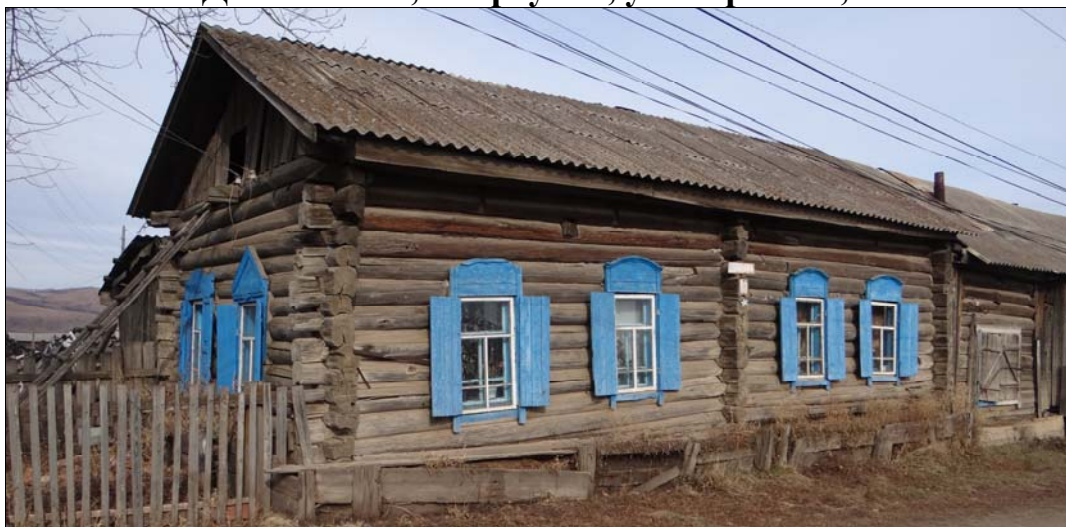
«Дом жилой», с. Аргунск, ул. Вершина, 20
