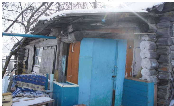
Прируб северного фасада
